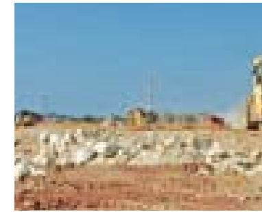
25 de Junio Inicio de la obra
