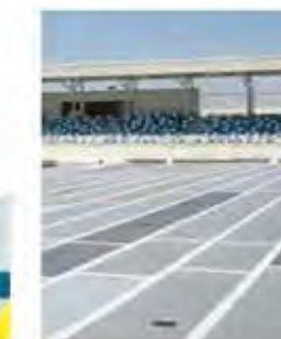
Base elástica instalada.
