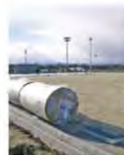
Presentación de los rollos en la obra.
