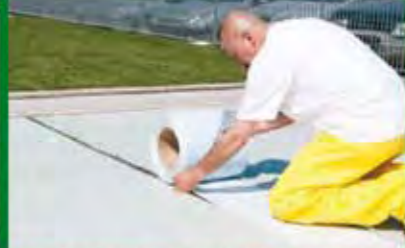
2. EXTENDIDO Y UNIÓN DE LOS ROLLOS DE BASE ELÁSTICA FINE TUNED
