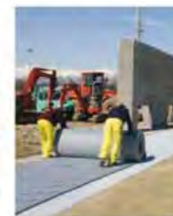
Extendido de rollos sobre la lámina nodular.
