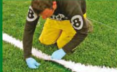
4. UNIÓN DE ROLLOS E INSERCIÓN DE LÍNEAS DE MARCAJE
