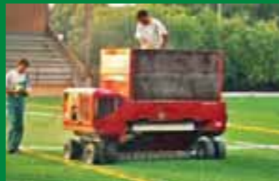
4 MARCATURA DELLE LINEE DI GIOCO 5 INTASAMENTO DEL MANTO
