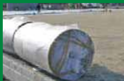
1 CONSEGNA DEL MATERIALE IN CANTIERE
